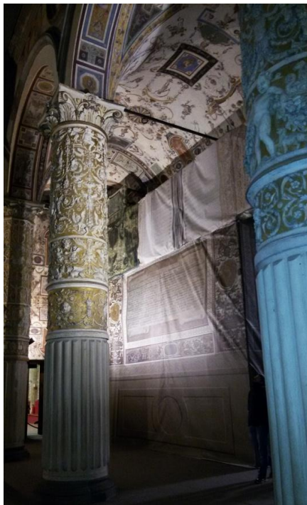
Pohľad na prebiehajúce práce
